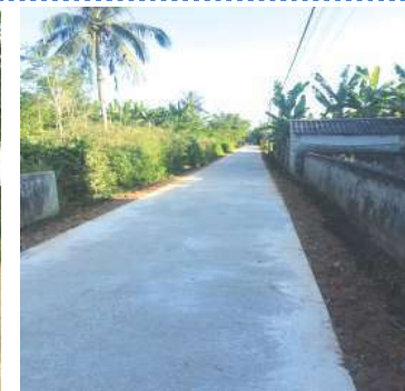
Hình 17: Đường nội thôn xóm Chắp Bắc, xã Vĩnh Chắp, huyện Vĩnh Linh, Quảng Trị do người dân thi công, giám sát
