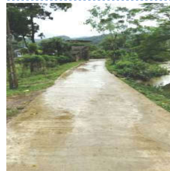
Hình 16: Đường nội thôn xóm Vai Đào, xã Cao Rằm, huyện Lương Sơn, Hòa Bình do người dân thi công, giám sát
