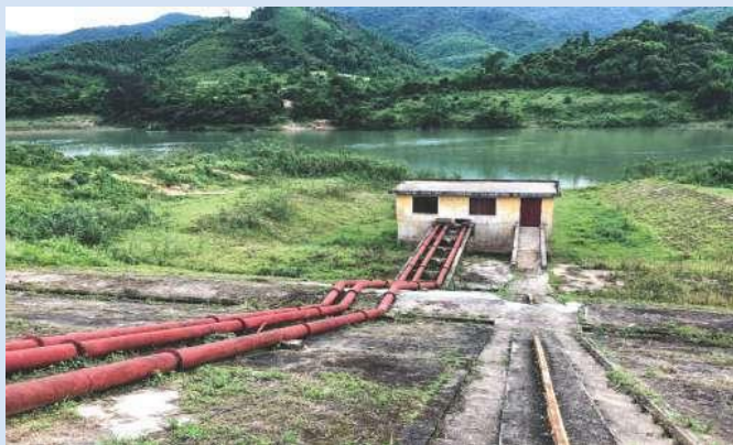
Hình 9: Công trình trạm bơm xã Mò Ó
