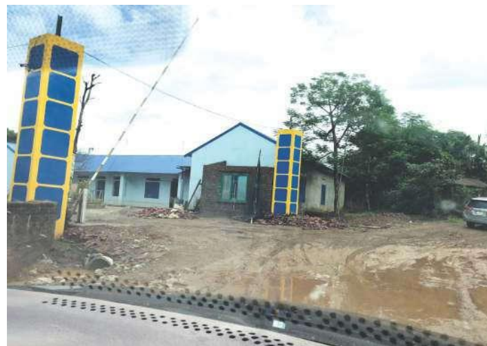
Hình 6: Đường sá bị xuống cấp do hoạt động của nhà máy gạch xã Cao Râm, Lương Sơn, Hòa Bình
